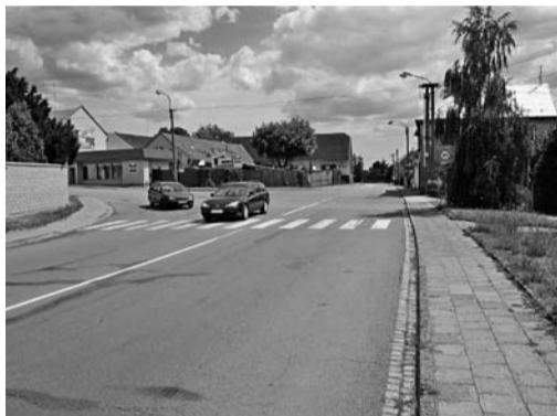
Nebezpečný přechod pro chodce na ulici Pplk. Sochova v Drozdíně. Přechod není označený, nemá předepsané osvětlení a jeho délka 13 metrů je dvakrát větší, než dovoluje norma.
