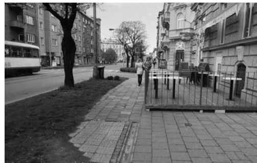
Chodníky v Masarykově ulici jsou ve špatném stavu. Jsou na nich nelogicky umístěny některé předzahrádky. Pruh zeleně je na mnoha místech prošlapán na hlínu.
